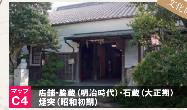
店舗・蔵(明治時代)・石蔵(大正期) 煙突(昭和初期)
